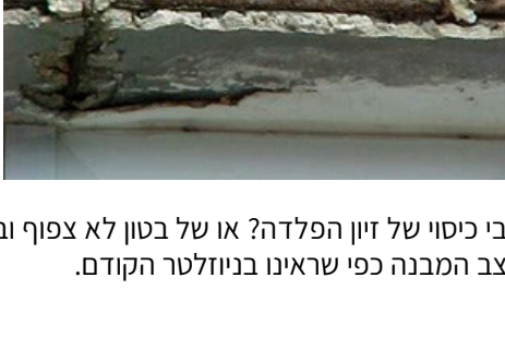
האם הבעיה היא בעובי כיסוי של זיון הפלדה? או של בטון לא צפוף ובחזק נמוך? להלן תהליך הערכה של מצב המבנה כפי שראינו בניוזלטר הקודם.
