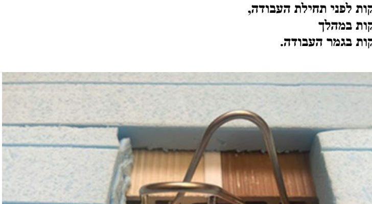
דוגמא של חיבור אריחי טרקוטה דרך בידוד תרמי. את הבטון יוצקים כנגד הבידוד התרמי
